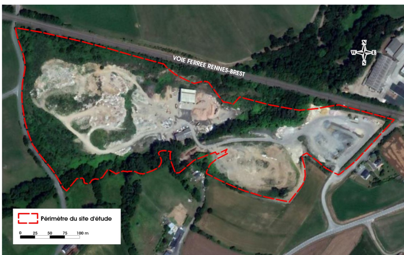
Figure 12 : Aire d'étude du site
