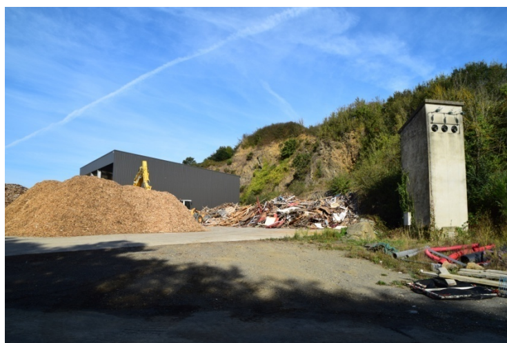
Plateforme de stockage et bâtiments
