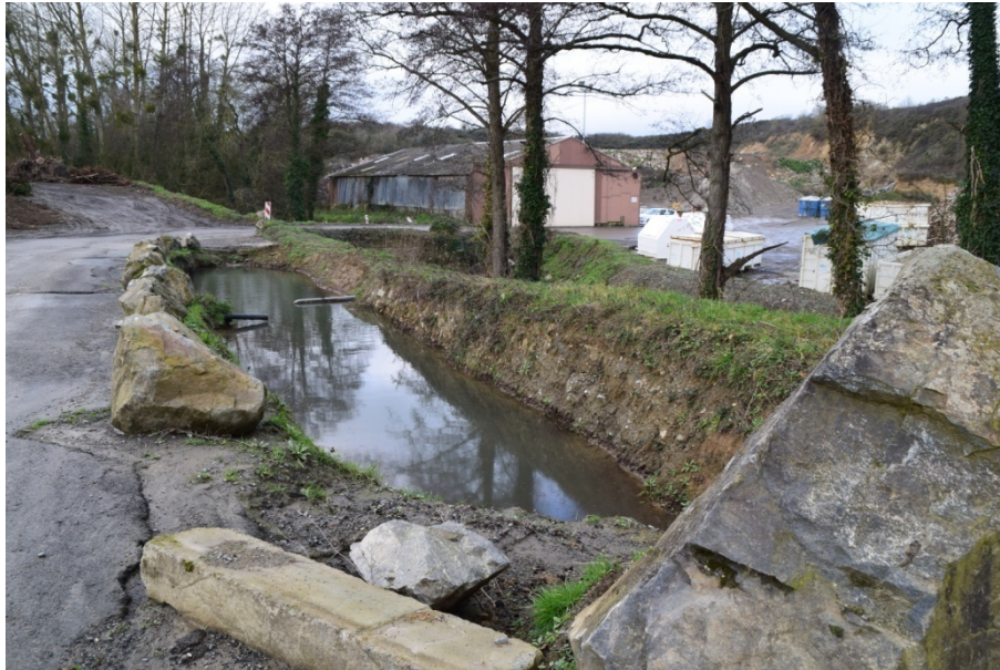
Vue sur le bassin Sud du site
